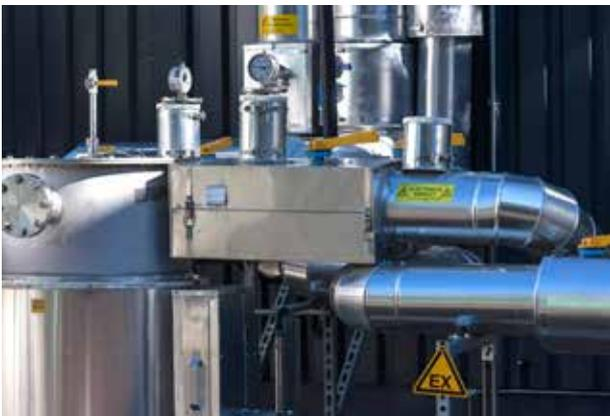
Das Schwimmschlamm-Entnahmesystem besteht aus einem im Inneren des Schlaufenreaktors installierten Schwimmschlammkasten. Durch Anstauen des Gärreaktors steigt der Wasserspiegel und der Schwimmschlamm wird über den Schwimmschlammkasten ausgeschleust.
